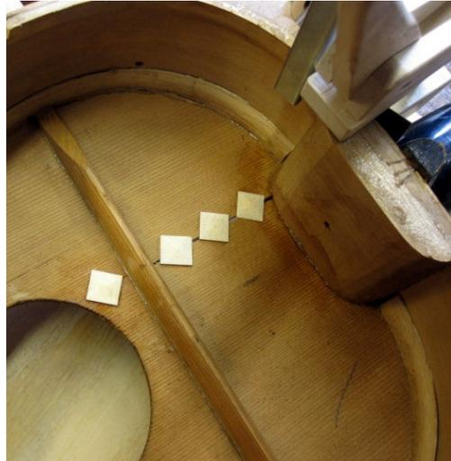
Nach dem Trocknen der Rissflanken, wurde durch exaktes Vorschneiden mit einem scharfen Skalpell ermöglicht, den Span einlegen zu können. Dabei wurde kein Material entfernt, sondern nur die Rissflanken etwas auseinander gedrückt. Vor dem Einlegen des Spanes wurde der Riss mit aufgeleimten Futterplättchen aus Fichtenholz nivelliert.
